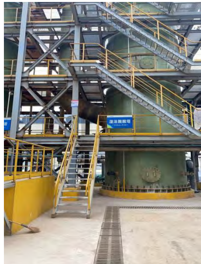
废气治理设施标识牌
